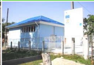
STAȚIE CLORINARE ANINOASA (VJ-CL03)
