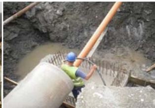
CAMERĂ ELECTRICĂ (VJ-CL01)
